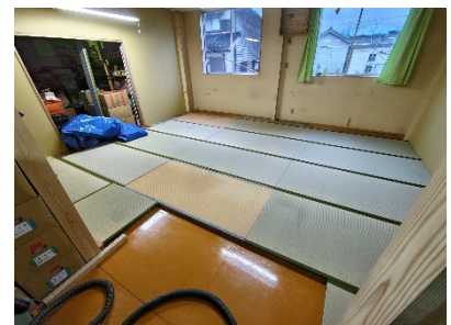
リフォーム経過 床張り、間仕切り、畳敷きなど行いました。
