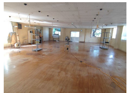
移転先の工場の内装 様々な資材がありましたが流用できない為、自費撤去しました。
